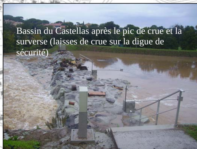
Surverse par la digue en rive gauche bien après le pic de crue
