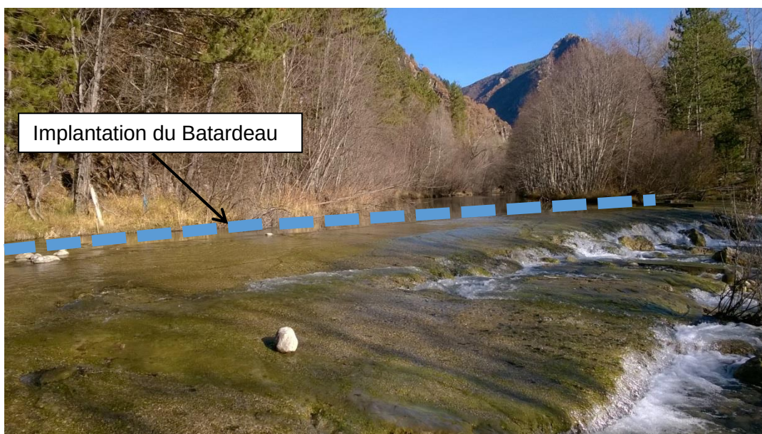
9. Implantation du batardeau
