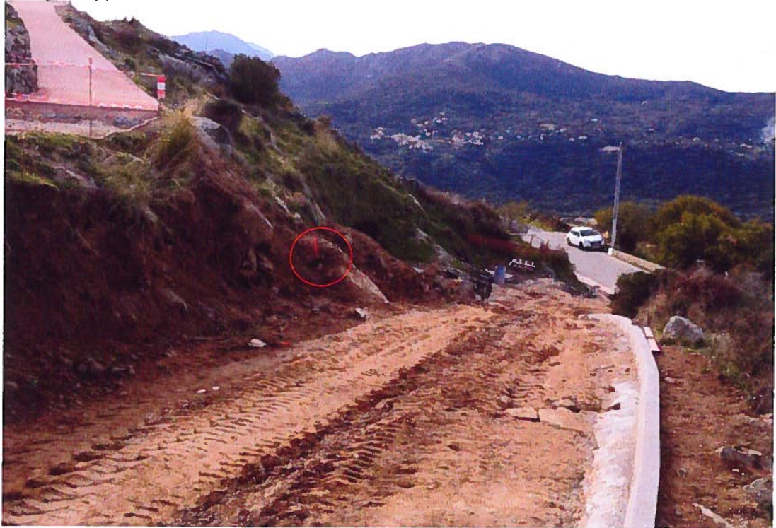
Fouilles du mur et 1er éperon rocheux dégagé
