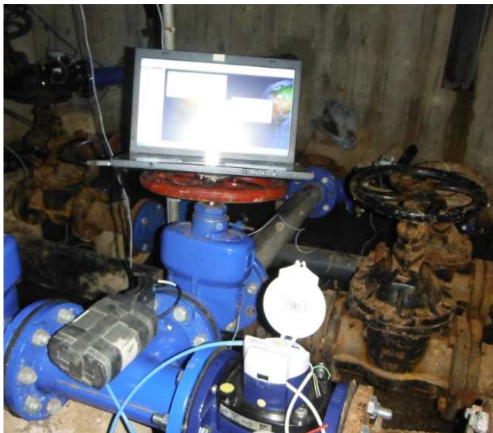
Figure 5 : Programmation et relève du logger.
