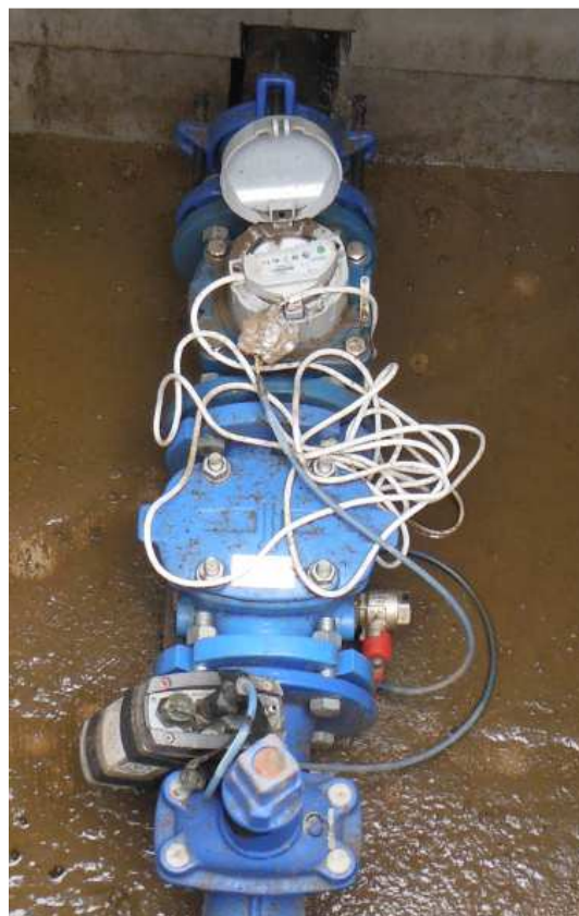
Figure 6 : Logger et tête émettrice.
