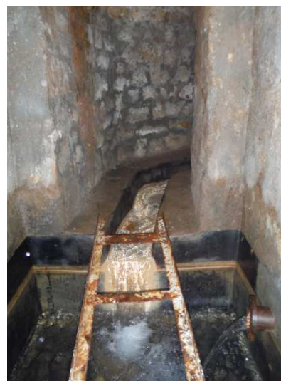
Figure 20 : Arrivée de la galerie drainante dans le captage.
