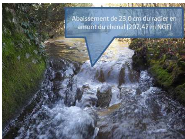
Entrée du chenal en aval du tronçon court-circuité
