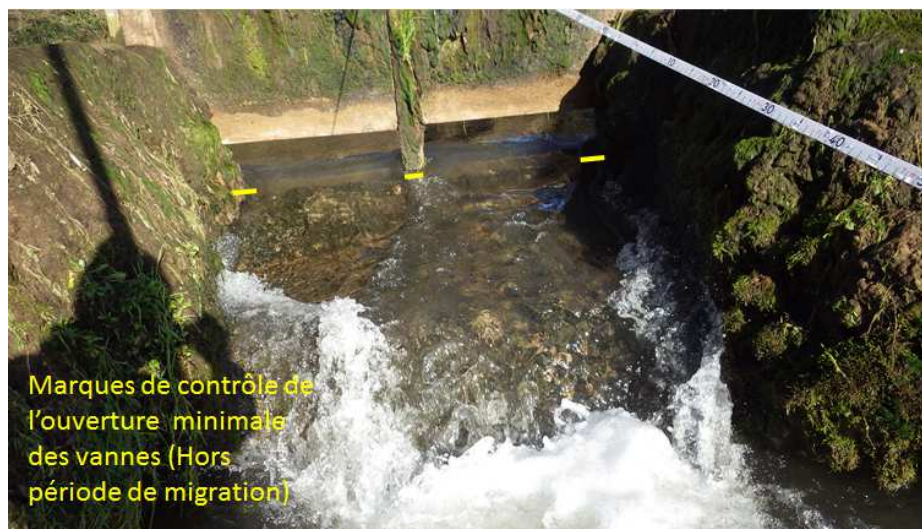
Marquage des repères pour le contrôle du débit réservé hors période de migration
