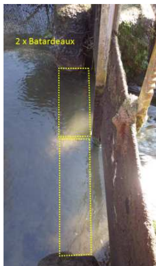
Mise en place de 2 batardeaux en période de migration optimale
