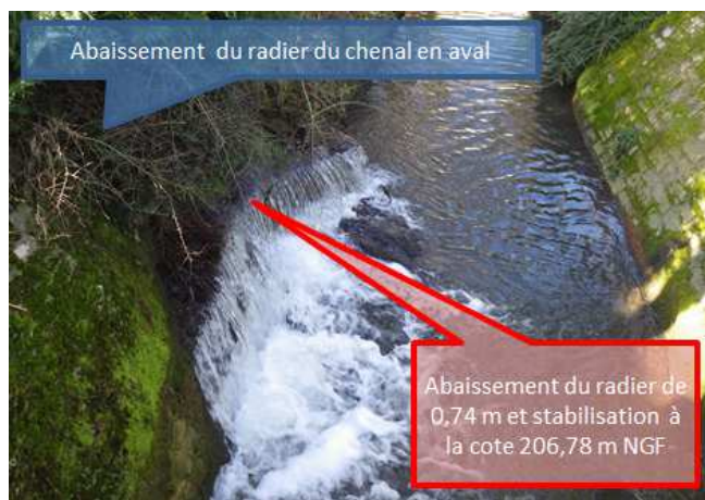
Aménagement de la zone aval du chenal
