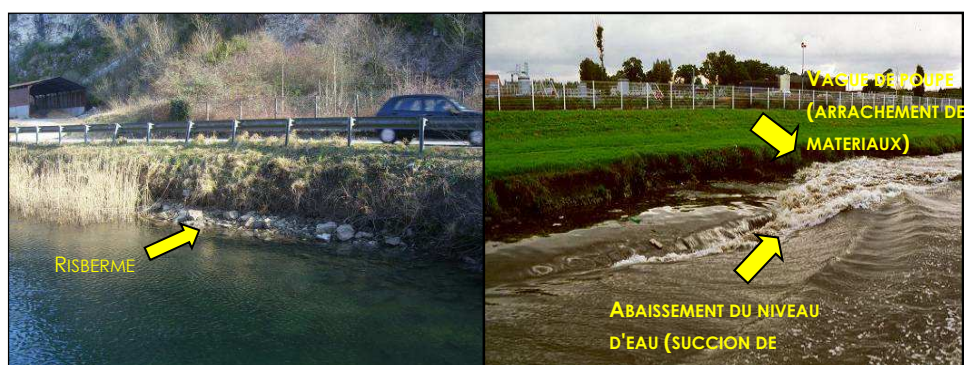
Figure 5. Effets caractéristiques du phénomène de batillage en bordure d'un cours d'eau navigué (la Lys, image de droite). Illustration du processus de sapement de berge, en rive gauche du canal de Savières le long de la RD 18 (image de gauche). Biotec – 2008.28.01.
