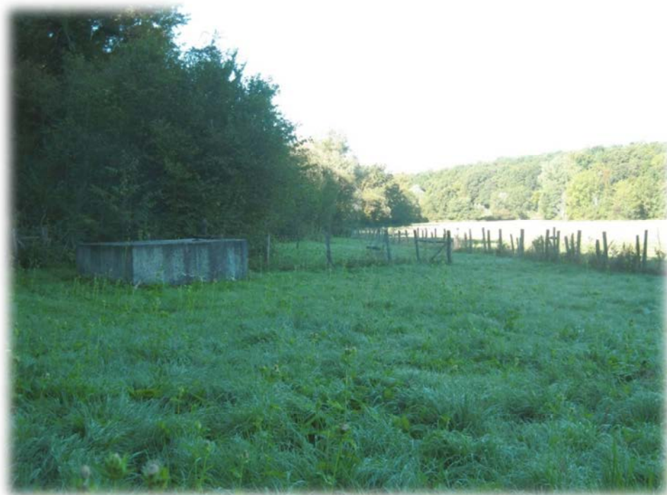
Ouvrage de collecte des sources du Bas de la Côte à VAUCONCOURT NERVEZAIN
