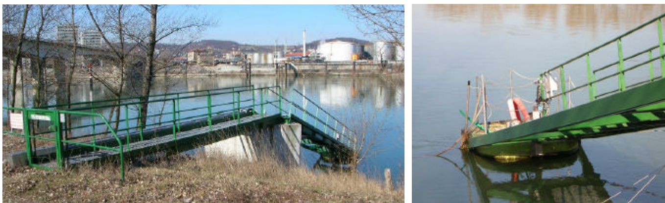
Figure 3 – Le bras de prise d'eau (à gauche) et la coupole flottante (à droite).
