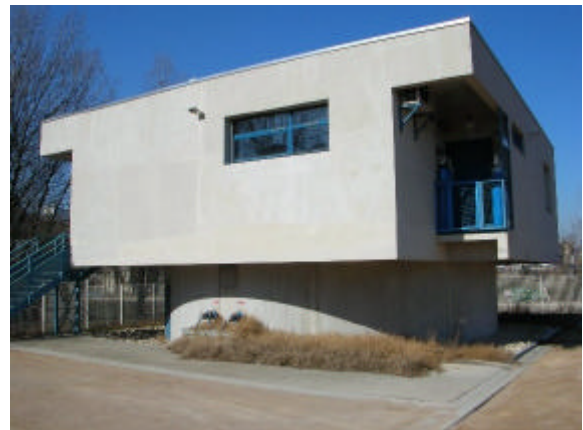
Figure 1 – Vue extérieure de la station de Ternay au bord du Rhône. La station est construite sur un pilier, ce qui permet de pas gêner l'écoulement des eaux en crue.
