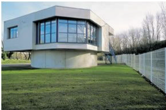
Figure 1 – Vue extérieure de la station de Ternay au bord du Rhône. La station est construite sur un pilier, ce qui permet de pas gêner l'écoulement des eaux en crue.
