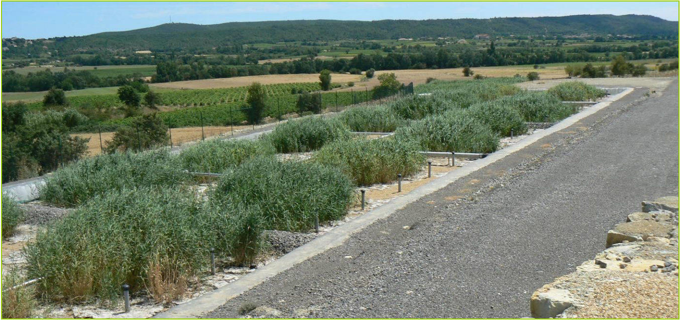
Illustration 2 : Exemple de Lits Plantés de Roseaux
