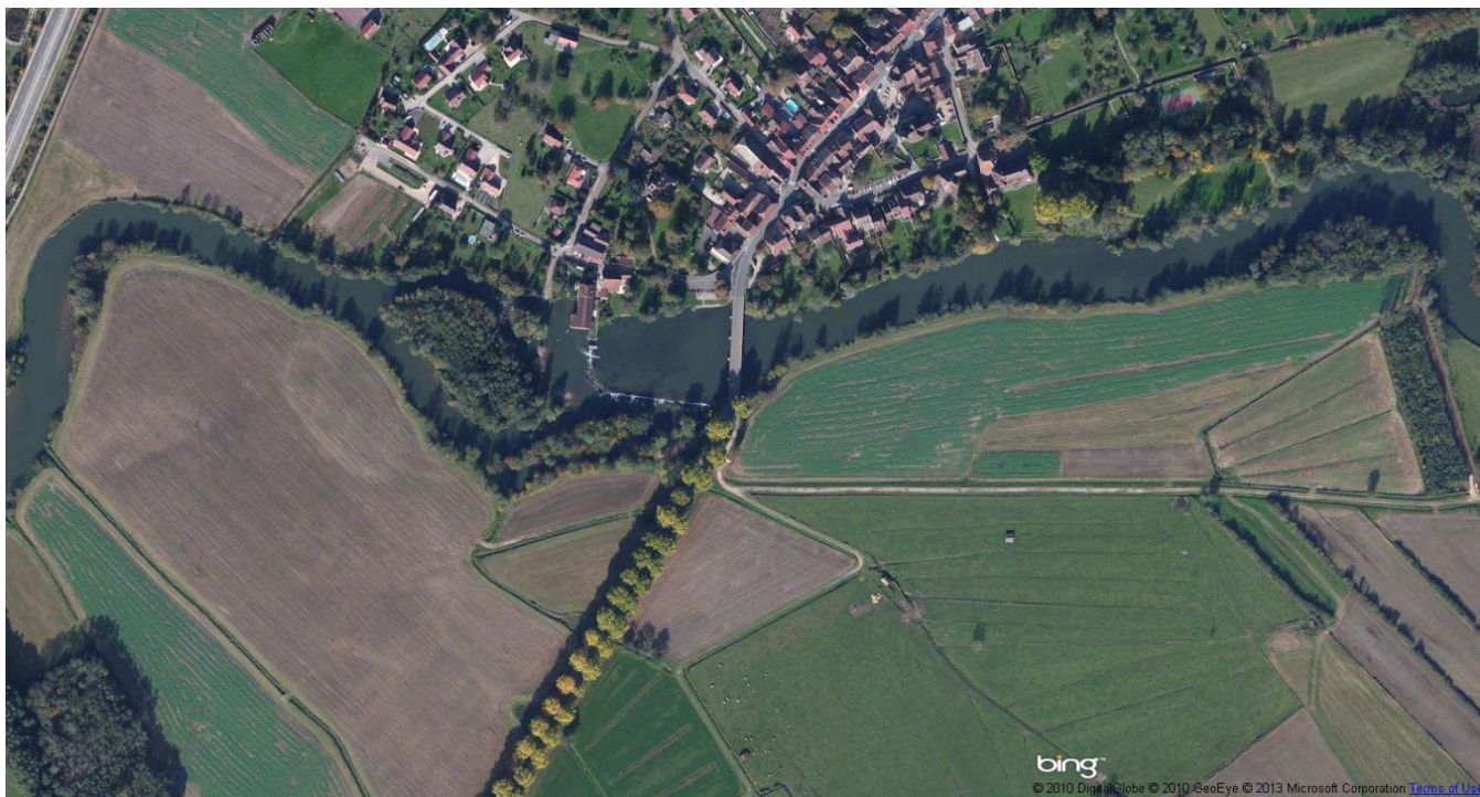
Figure 2 : Photo aérienne du seuil de Voray
