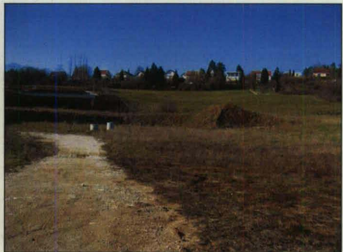
Le Point du Jour, exutoire des eaux pluviales
