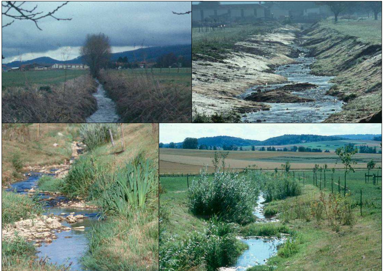
Fig.03 : Exemple de travaux de décorrection de cours d'eau menés cependant au sein d'une emprise foncière limitée : Etat du lit avant travaux de décorrection de la Cornoline (Illustration en haut et à gauche - 14.02.00), puis au cours des travaux de terrassement (Illustration en haut et à droite - 27.09.01), puis, enfin, environ deux années après végétalisation des abords du ruisseau (Illustrations du bas - 09.07.03).
