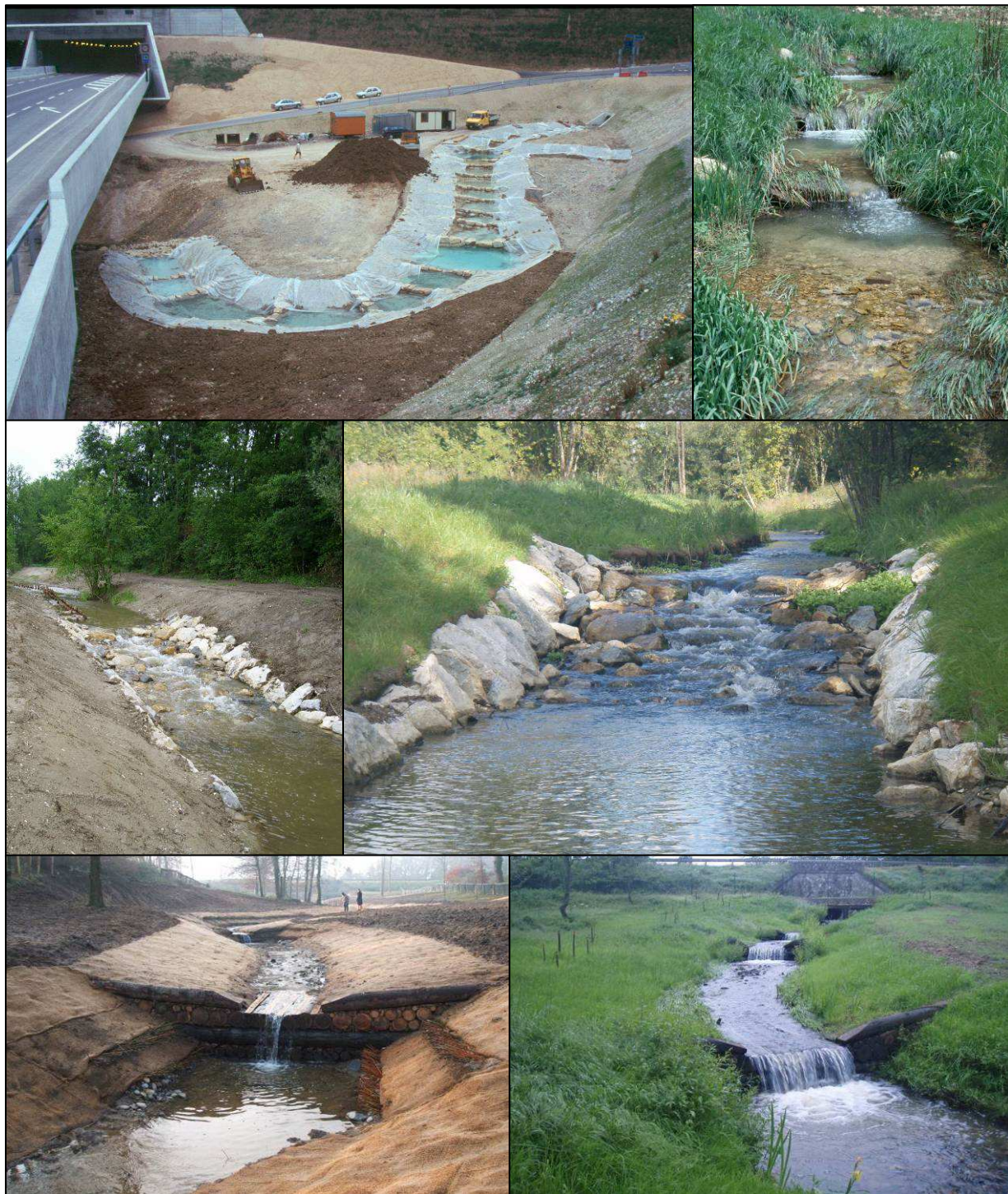
Fig.01 : Exemple de micro-seuils (illustrations du haut) et rampes en blocs avec de dissipation d'énergie (illustration du milieu) mis en œuvre sur les cours du Malrang et de la Deysse. Barrages bois établis sur le ruisseau de la Tamina (69) – avant et après végétalisation (illustration du bas).
