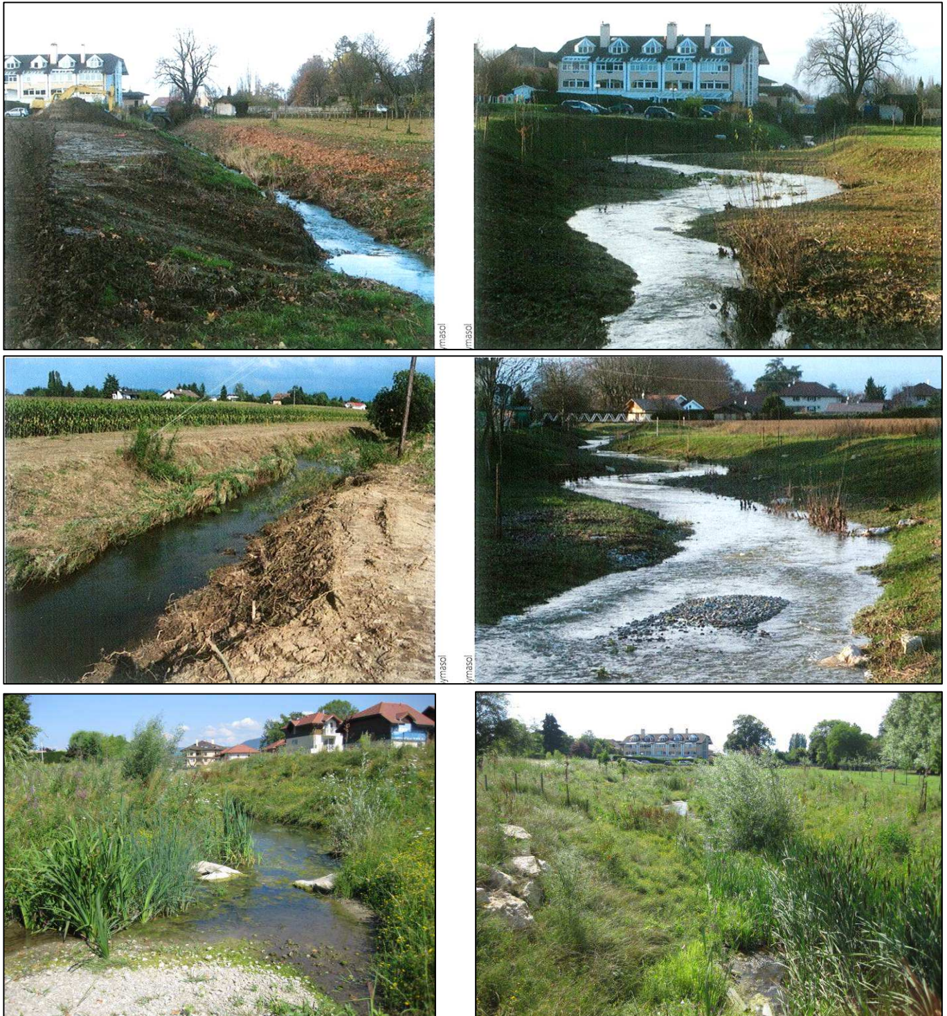
Fig.04 : Exemple de chantier : restauration de l'Hermance dans la traversée du bourg de Veigy. A gauche, l'Hermance recalibré avant travaux, en aout 2008. A droite, l'élargissement de la section du lit mineur et la plantation en berges, en décembre 2009. Image du bas, deux ans après réalisation des travaux (juillet 2010).
