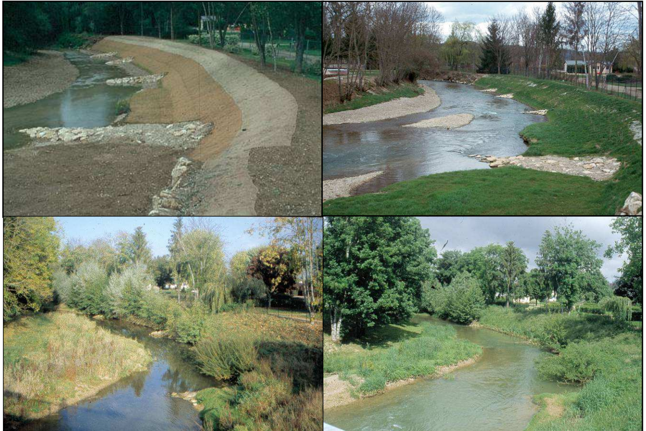
Fig.05 : Travaux de mise en place d'épis déflecteurs (18.09.01), puis état des ouvrages au début de reprise végétale (formation de premiers atterrissements) (14.03.02) et développement végétal quatre et cinq années après travaux (19.10.05 & 30.05.06).
