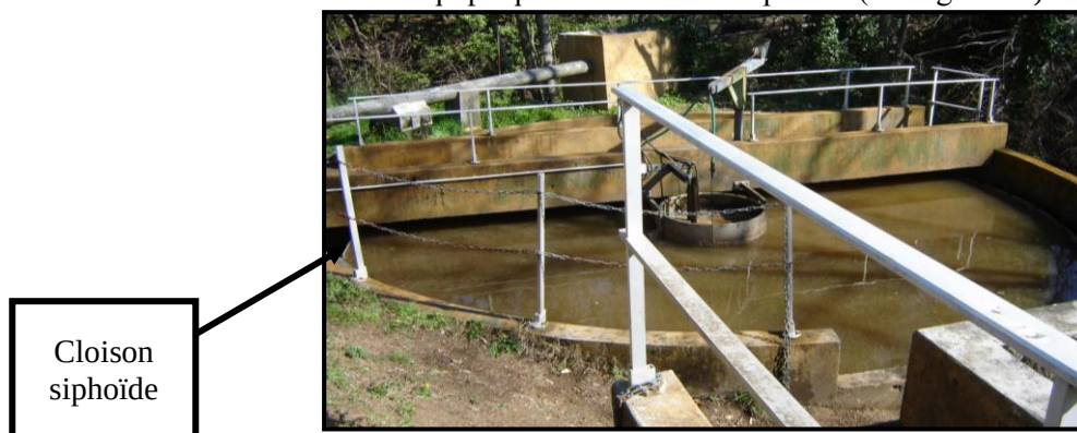
Figure 15 : Cloison siphonide du clarificateur
