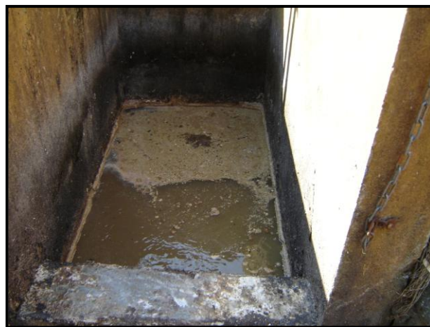
Figure 3 : STEP Thueyts : dégraisseur
