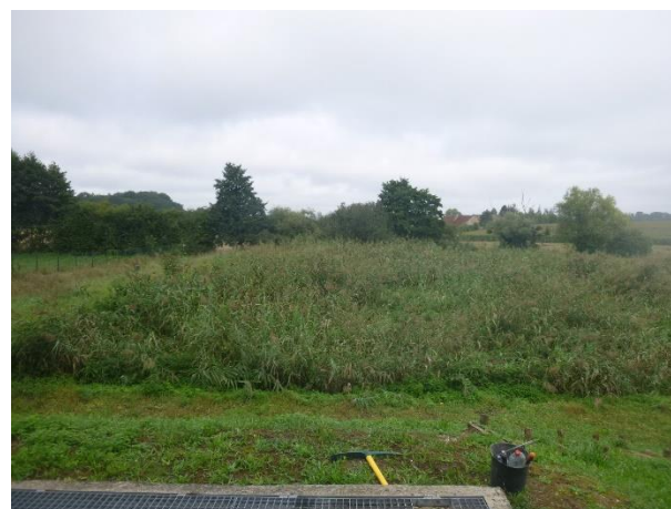
1 er étage de filtre planté de roseaux
