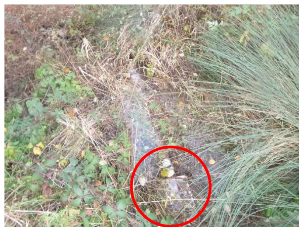
Clapet anti-retour en aval de la surverse
