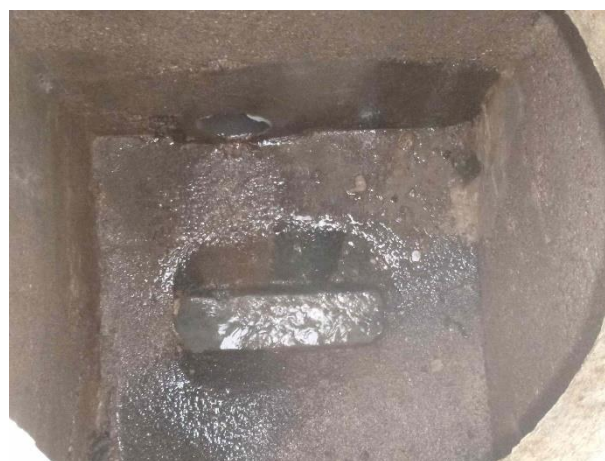
Suppression des apports après réhabilitation
