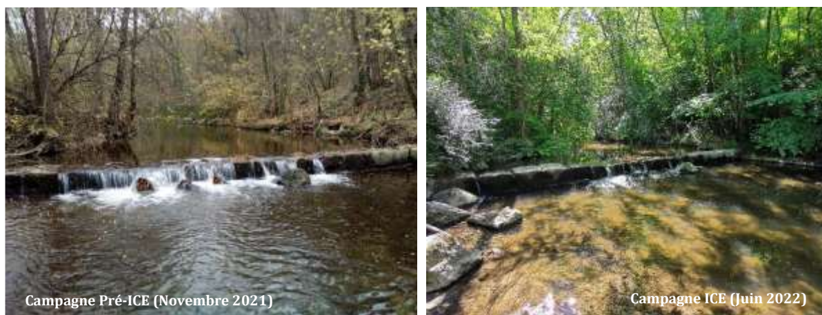
Figure 2 : Photographies du seuil ROE42880 / n°3 sur les deux campagnes d'investigations – Source : Gay Environnement et Améten (2021-2022)
