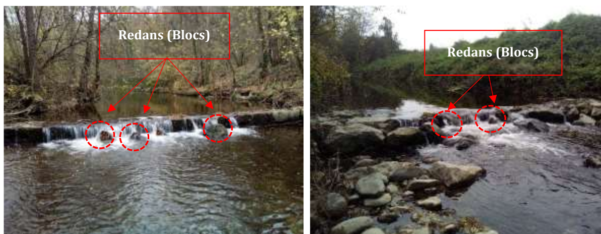
Figure 16 : Localisation des redans limitant en dévalaison sur les ouvrages n°3/9 de l'Aire – Source Améten/Gay Environnement 2021
