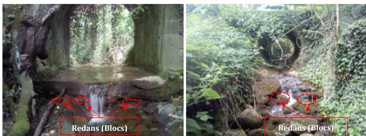
Figure 5 : Localisation des redans limitants en dévalaison sur les ouvrages du Grand Nant (5/7) – Source Améten/Gay Environnement 2023
