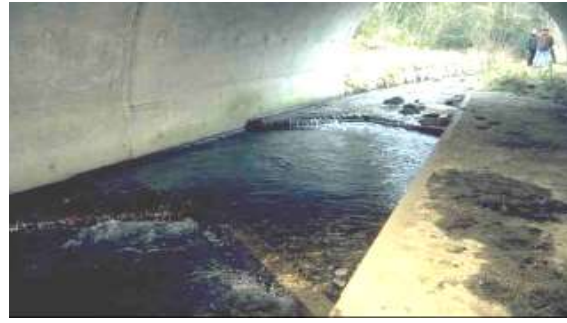
Figure 9 : Exemples de dispositifs défecteurs de type cloisons- source CEREMA
