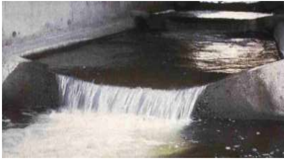
Figure 9 : Exemples de dispositifs défecteurs de type cloisons- source CEREMA
