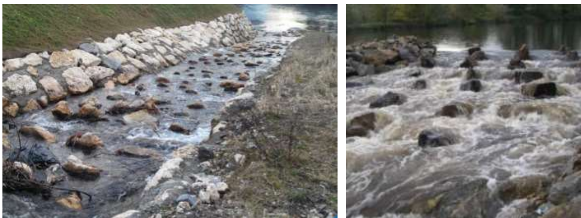
Figure 6 : Exemples de rampe en enrochement – source : ARRA
