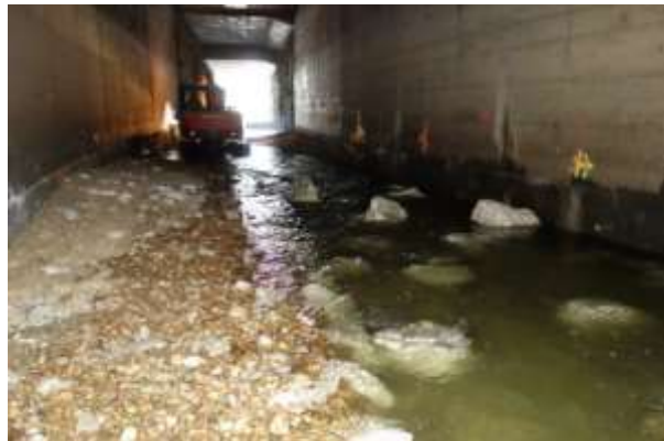
Figure 10 : Exemples de macrorugosités installés dans un radier de pont - source CD37
