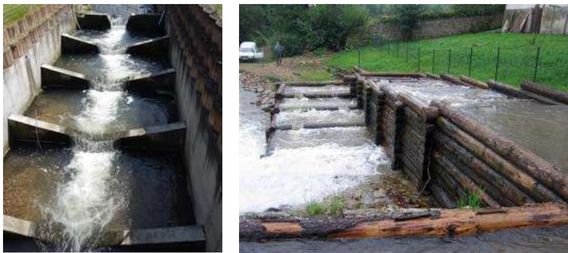
Figure 7 : Exemples de passe à poissons à bassins successifs – source SMBVT
