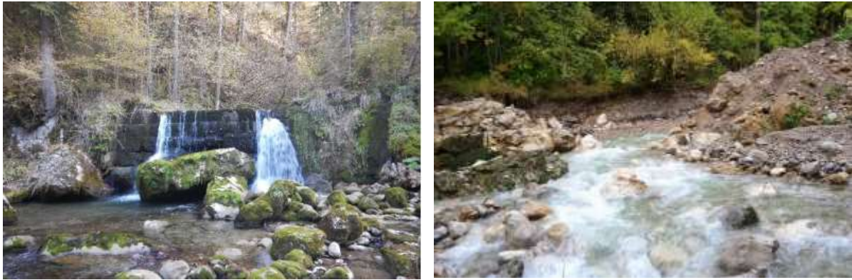
Figure 11 : Exemple de dérasement sur un seuil en pierre de taille – Source : D.ANGELIN
