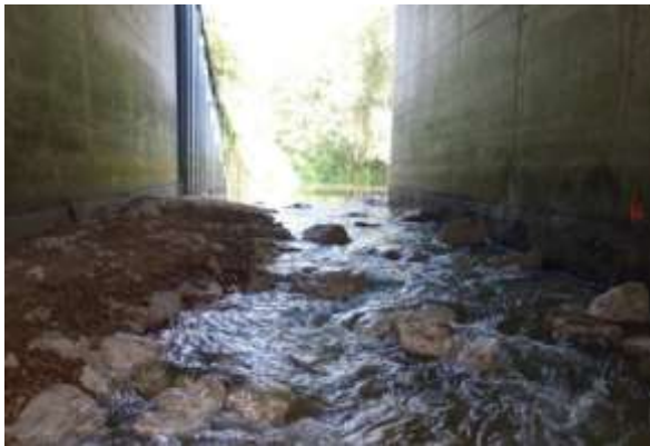
Figure 10 : Exemples de macrorugosités installés dans un radier de pont - source CD37
