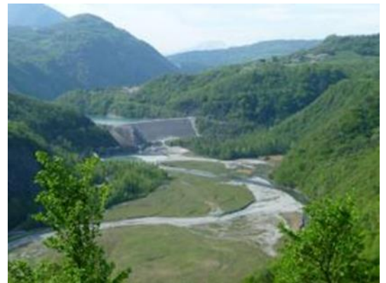
Vue de la limite amont de la RNR (Barrage de Notre-Dame-de-Commiers) depuis Chabotte, rive gauche (©RNR).
