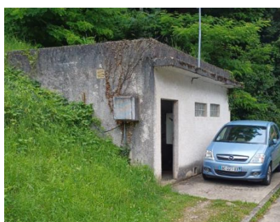
Figure 15. Station de pompage du Quinot.
