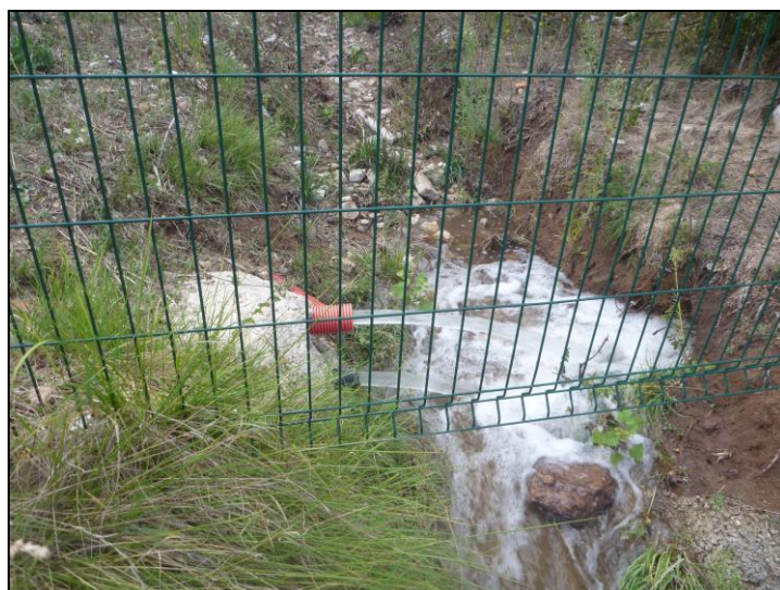
Figure 2 : Déversement observé en temps sec
