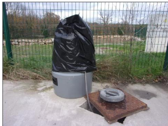
Figure 3 : Regard de prélèvement et préleveur 24 flacons – CTMS
