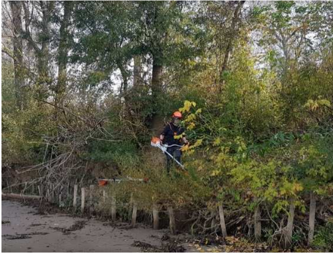
Entretien des fascines en 2018 et reprise constatée en 2019
