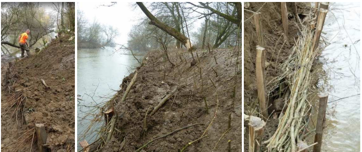
Chantier de pose de fascine et bouturage - fin mars 2013
