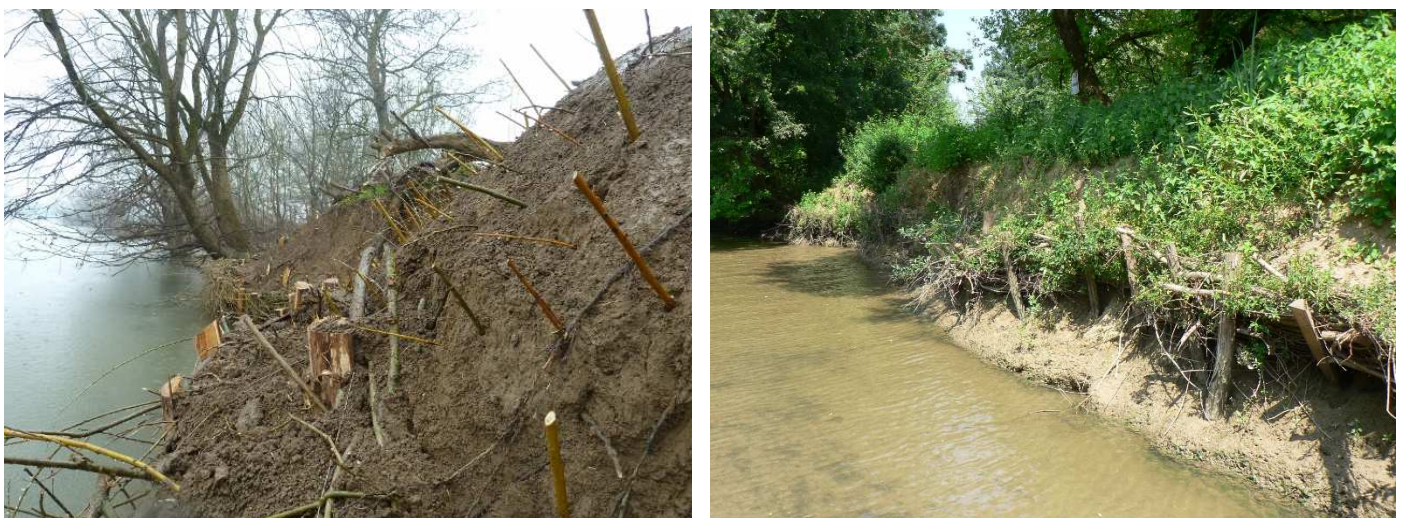
Reprise de la végétation et état des fascines en juillet 2013 (en bas à gauche)
