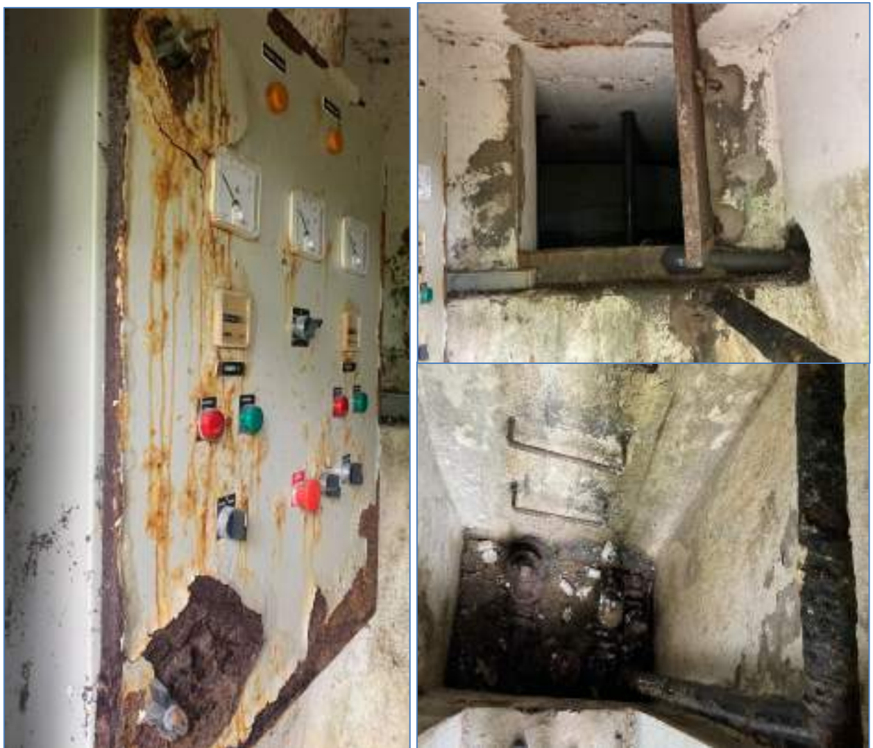
Photographies 11 : Chambre des vannes du réservoir R2
