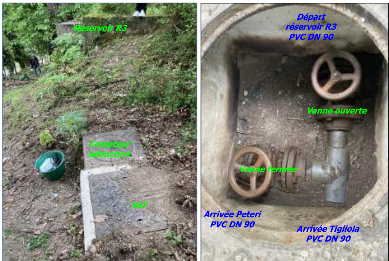
Photographies 9 : Vues intérieure et extérieure Va7
