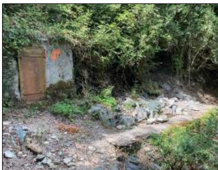
Photographie 6 : Vue extérieure de l'ouvrage de de dessablage et de partage
