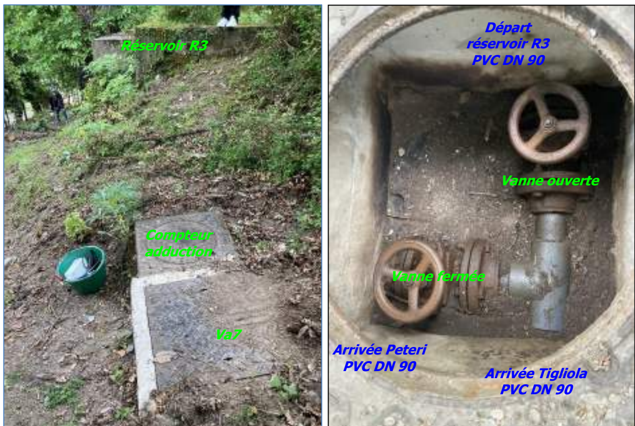
Photographies 9 : Vues intérieure et extérieure Va7
