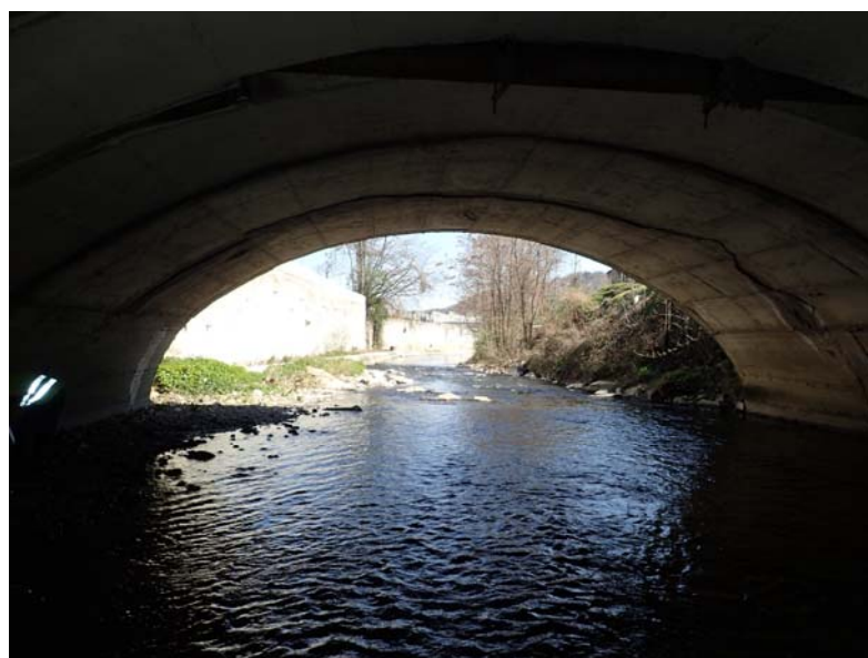
Figure 3-2 : section aval de la galerie du Gier (sous rond-point Gambetta / Juin)
