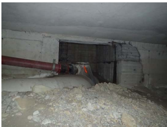
Figure 3-8 : Connexion du refoulement au collecteur syndical DN 1200
