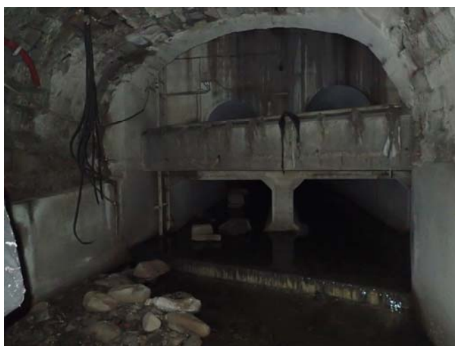
Figure 3-11 : Séparation aval Féloin / collecteurs syndicaux (DO8)
