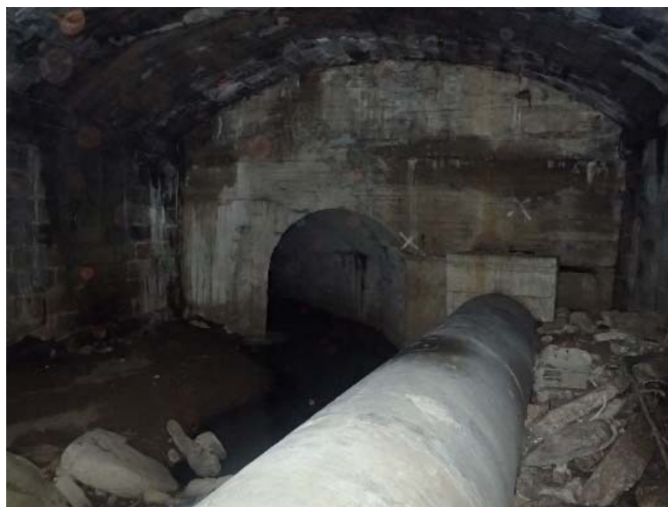
Figure 3-6 : Pénétration du collecteur syndical DN 1200 dans la galerie rive gauche du Gier
