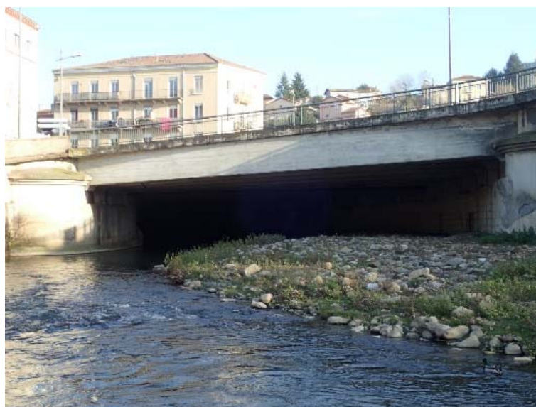
Figure 3-1 : section amont de la galerie du Gier (sous rond-point Charles de Gaulle / Mandella)
