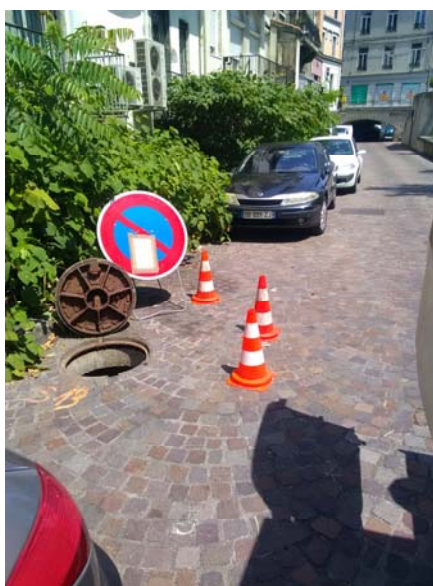
Figure 4-3 : Tampon sur chaussée
