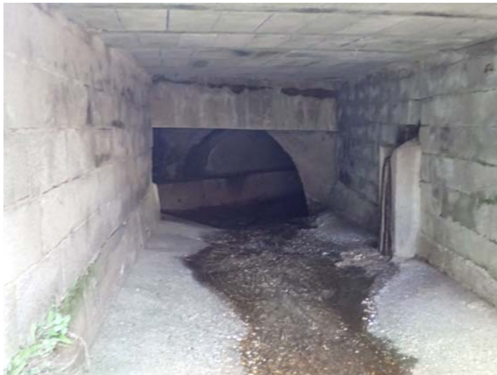
Figure 4-2 : Entrée galerie Féloin
