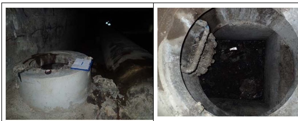
Figure 3-13 : Connexion d'un collecteur Ø300 SEM sur le collecteur syndical DN 1200
